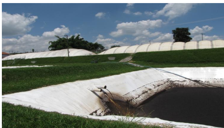
Biodigestor e lagoa de biofertilizante
